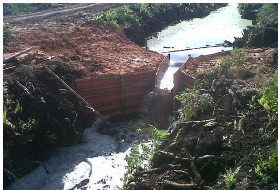
Gambar 4. Stop Log/Stop Block untuk pengendalian muka air saluran dan overdrainage .
