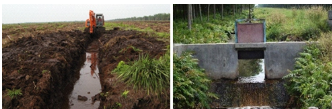
Gambar 1. Pembuatan parit drainase (kiri) dan pintu air permanen untuk mempertahankan ketinggian permukaan air (kanan)
