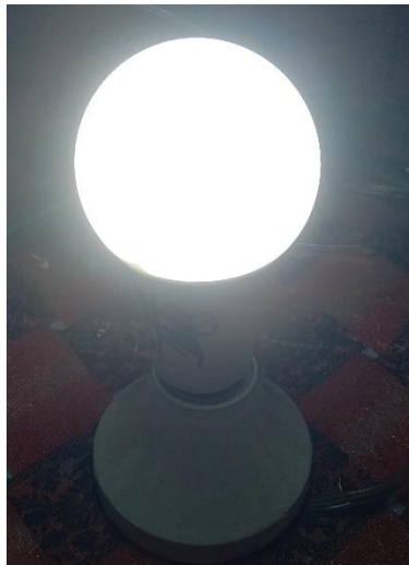
Gambar 2.6 Lampu yang sudah diperbaiki dan dipasang penutup lampu
