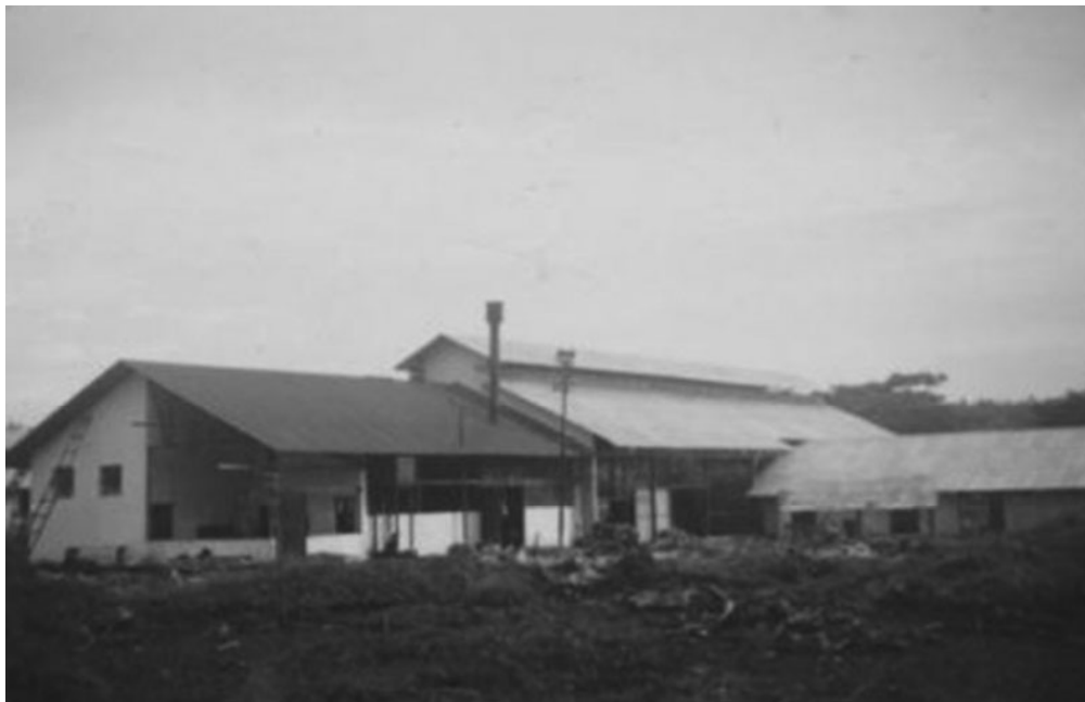
Gambar 8. Pembangunan pabrik karet utama di area perkebunan Tebenan di Onderafdeeling Banjoeasin en Koeboestrekken , 1938. (Sumber: kitlv.nl)
