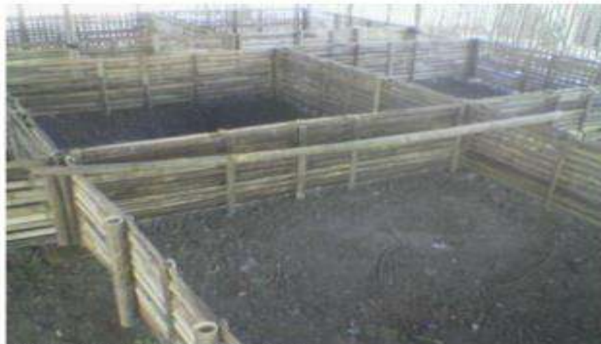
Rangka kolam menggunakan bambu
