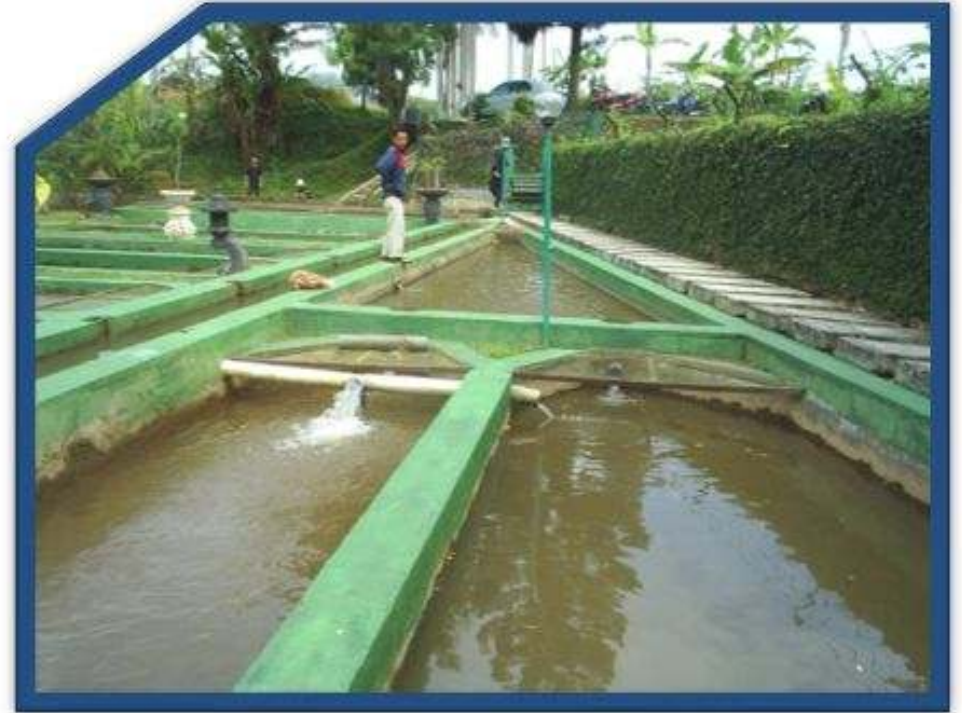
Kolam air deras
