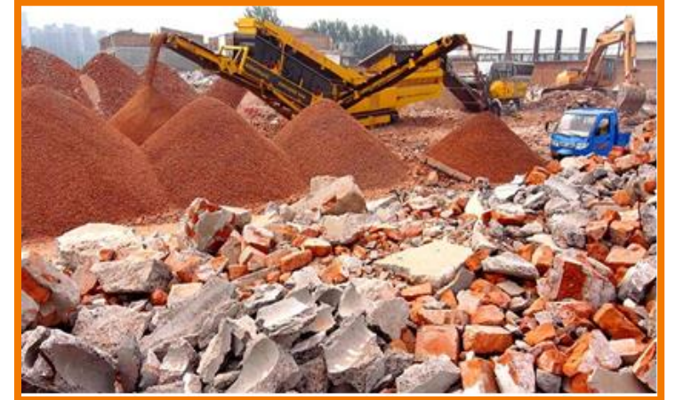
Daur Ulang Limbah Konstruksi
