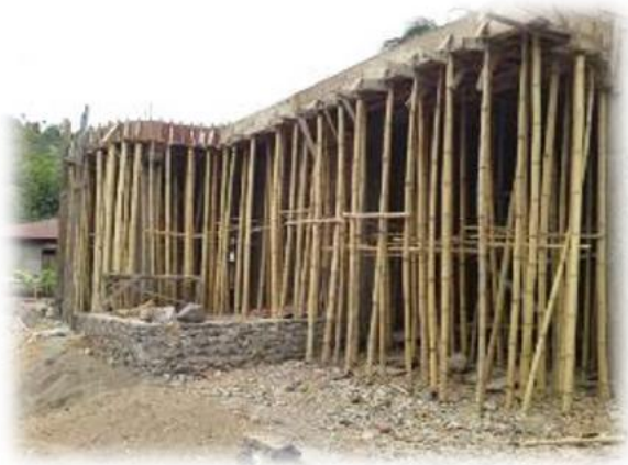
PERANCAH BAMBU DAN BEKISTING KAYU
