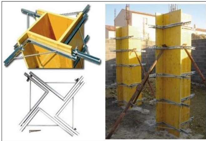
SISTEM PERANCAH BEKISTING
