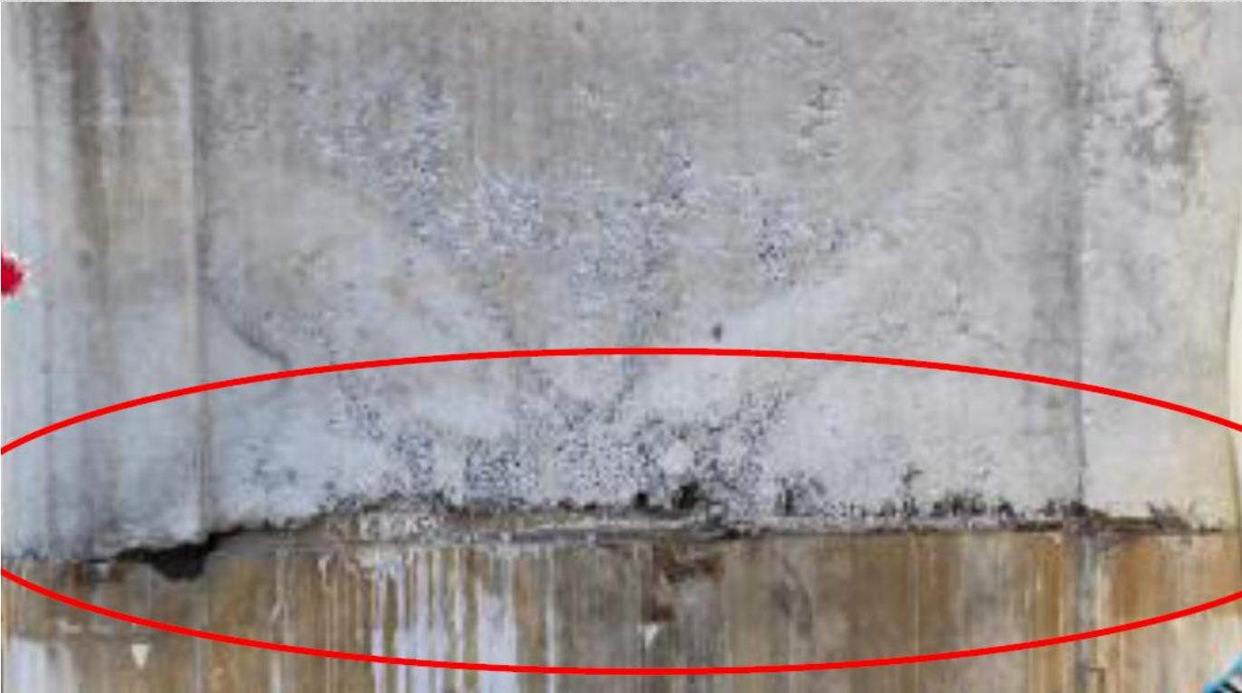
Pemisahan yang terlihat secara visual pada sambungan konstruksi. Hal ini disebabkan oleh kurang tepatnya penyiapan permukaan yang dilakukan pada daerah sambungan konstruksi. Berdasarkan ketentuan SNI 2847-2013 Pasal 6.4, daerah sambungan konstruksi harus dipersiapkan dengan baik.
