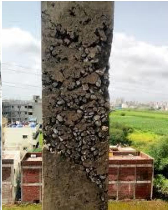
**Honeycomb** atau voids pada beton adalah lubang-lubang yang terbentuk pada beton dan relatif dalam dan lebar. Honeycom atau voids biasanya terbentuk di bagian dalam bekisting dan di daerah yang jarak tulangnya terlalu dekat.
